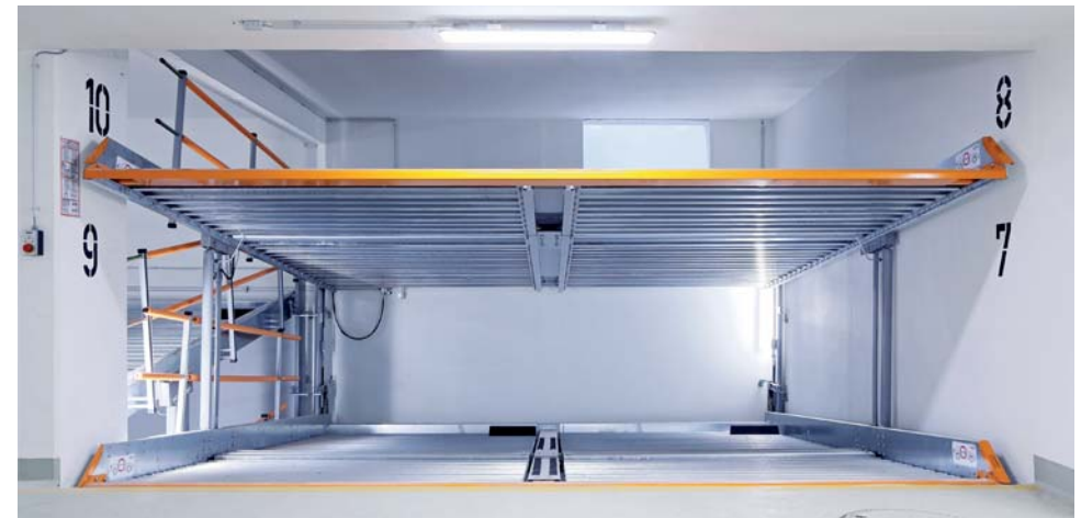
Tiefgaragenstellplatz im Kellergeschoss
