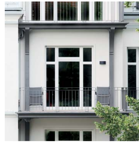
Balkonanlage in Stahlkonstruktion
