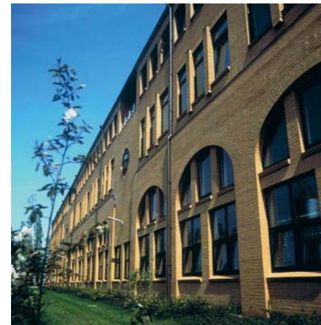
Der erste baubiologische Industriebau Deutschlands
